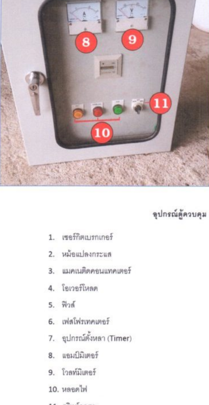
อุปกรณ์ตู้ควบคุม มอเตอร์พวงน้ำ
